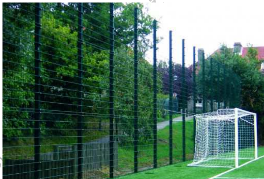
Foto 3. Widok ogrodzenia panelowego
