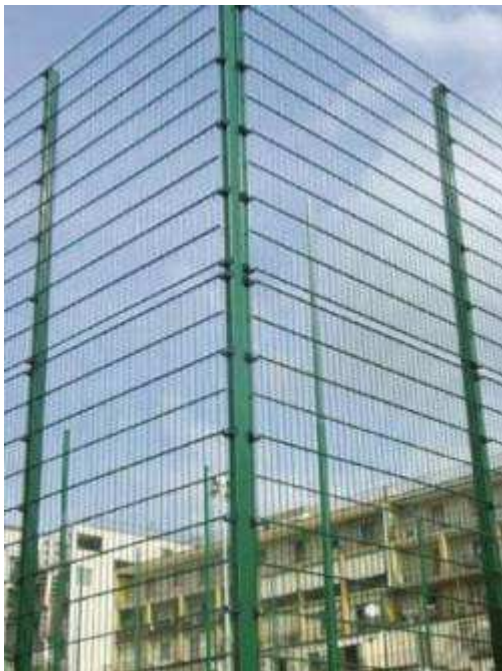
Foto 1. Widok ogrodzenia panelowego
