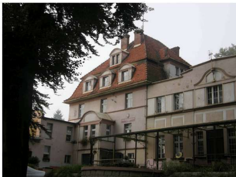
Foto nr 7 Budynek B Elewacja frontowa – wschodnia
