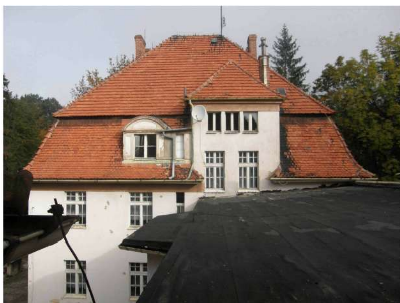
Foto nr 5 Budynek A – elewacja południowa - widok dachu z budynku B
