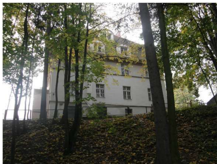
Foto nr 3 Budynek A –elewacja północna
