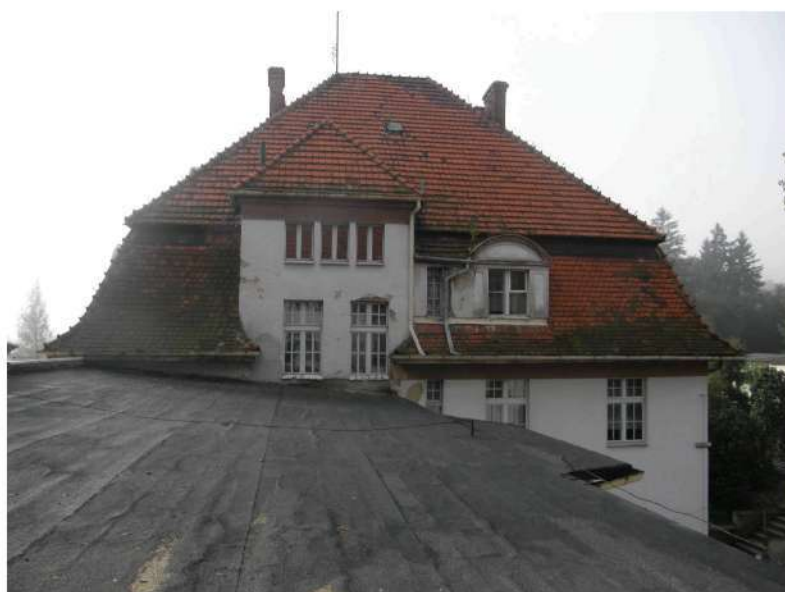
Foto nr 9 Budynek B – elewacja północna – widok z budynku A
