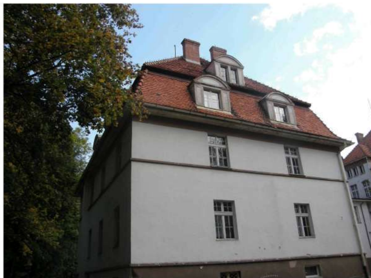
Foto nr 4 Budynek A – elewacja zachodnia
