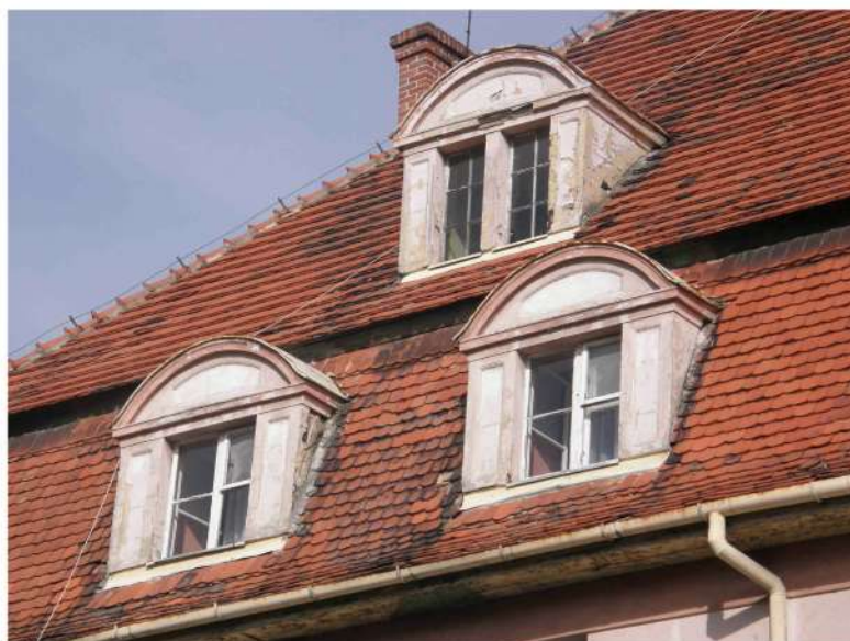
Foto nr 10 Budynek B – widok lukarn dolnych i górnej
