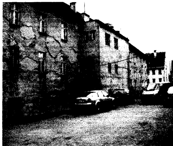
Budynek od strony parkingu
