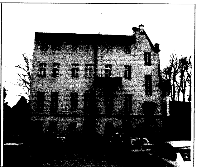
Budynek od strony parkingu
